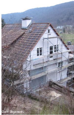
Dach abgedeckt.
